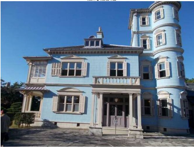
11. 明治時代建の洋館
