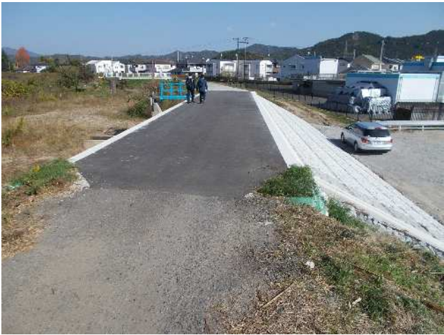
11新堤防(中島町地区)
