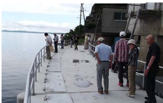
安積疎水の猪苗代湖取水工
