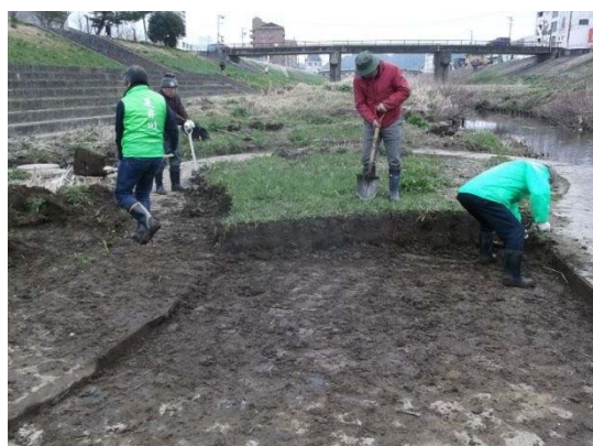
土砂撤去完了（3/5）
