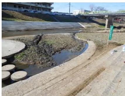
階段の土砂撤去と同時に、階段とひょうたん島の上に河川水が流れ込むように、スコップで水路をつくりました。
