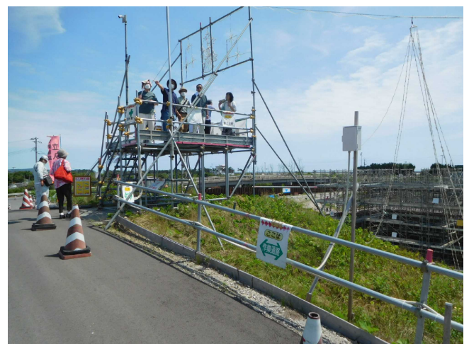
18 現地③仁井田川水門
